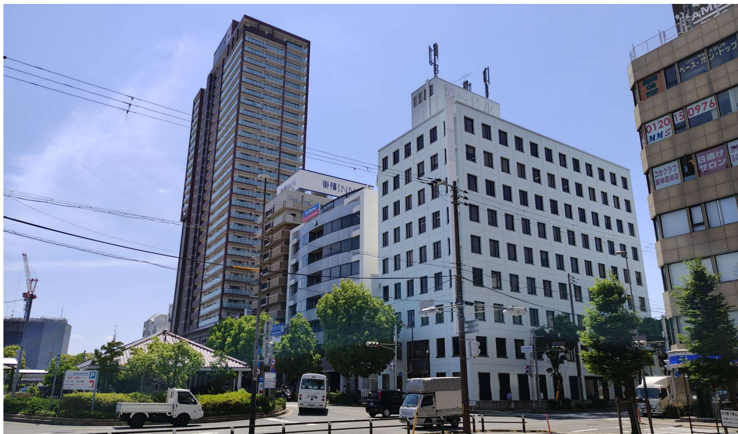
新事務所外観（尼崎第一ビル）
